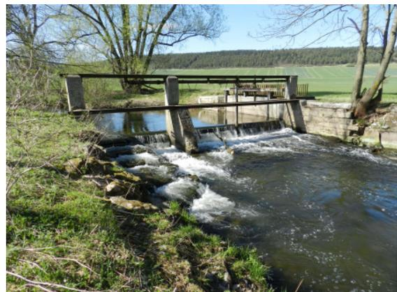
Abb. 5: Beispiel für eine nicht funktionstüchtige Fischauftiegsanlage. Wehr an der Ilm bei Großhetstedt (Foto: M. Dittrich)
