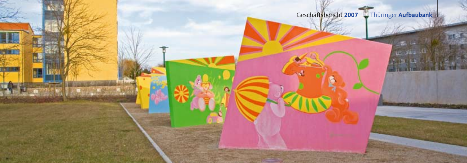
Außenflächengestaltung der Kita in Leinefelde
